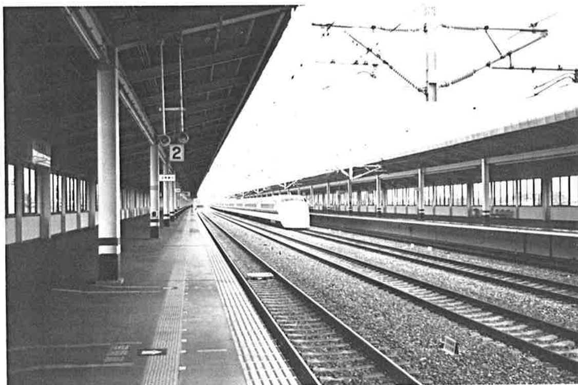
VUE D'UNE GARE TYPIQUE DU SHIN-KANSEN MONTRANT CLAIEMENT LES DEUX VOIES DE PASSAGE ET UN TRAIN NOZOMI QUI PASSE A 270 KM/H (PHOTO CLAUDE BINAME).
